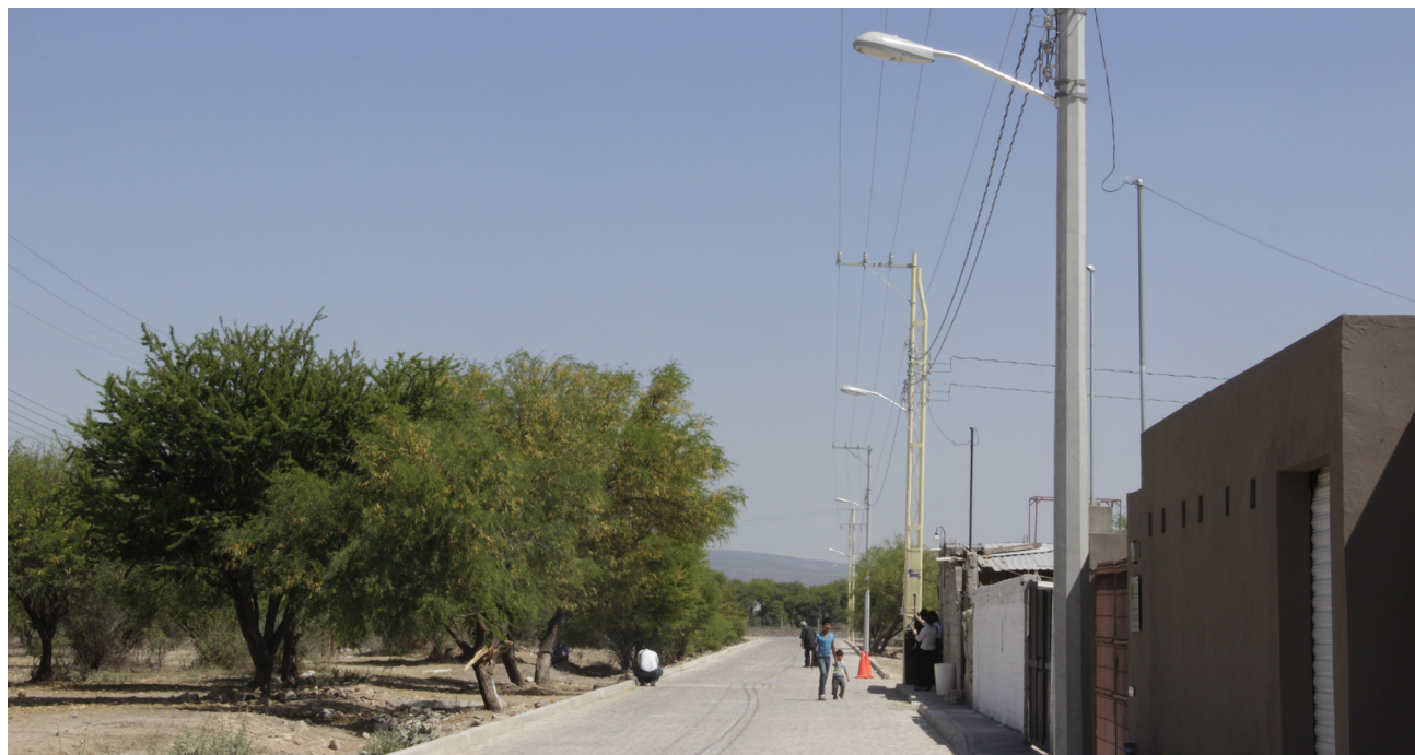
591 luminarias instaladas en 30 localidades.
